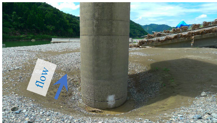
球磨川・沖鶴橋 局所洗堀 2020年08月26日14時撮影
