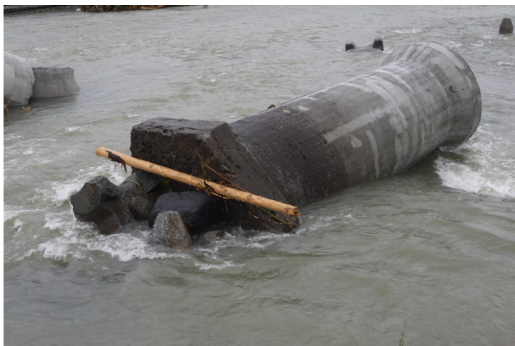
2017年(平成29年)九州北部豪雨 日田市 JR久大本線 橋脚転倒破壊
